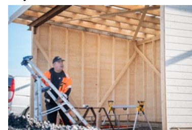
Marttilan Kaivuu ja Kuljetus Oy rakentaa uutta katosta. Pasi Kullannmäki (kuvasa) luotsaa yritystä isänsä Erkki Kullannmäen kanssa.
