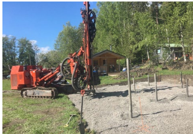
Tänä kesänä on tehty paljon porapaaluja. Kustaviin rakentui pohja saunamökille.
