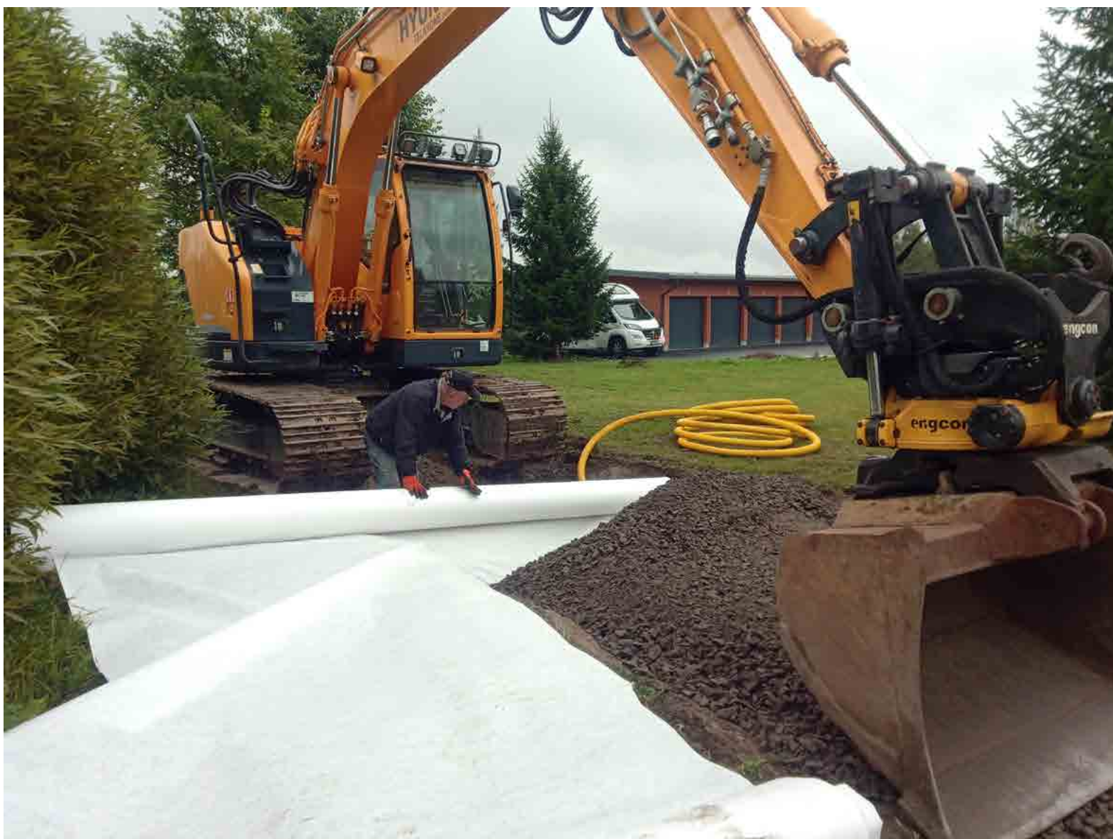
Maanrakennus M. Mäkinen Oy tekee maansiirtotyöt talkoilla. Koneen puikoissa Markku Mäkinen, suurena apuna on ollut Seppo Sollo. (Kuva: Hannele Tanner-Penttilä)
