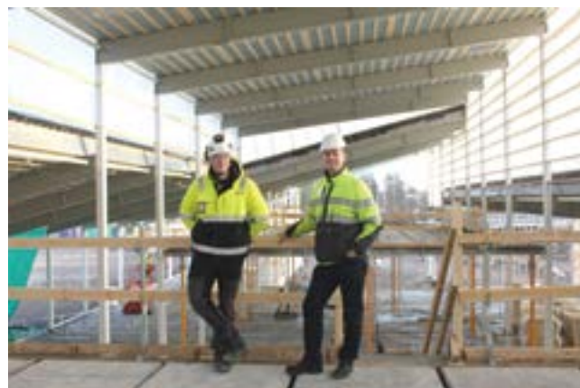
Tekninen johtaja Tarmo Rantanen ja vastaava työnjohtaja Mats Siven, taustalla juuri rakenteilla oleva Riihikosken yhtenäiskoulu
